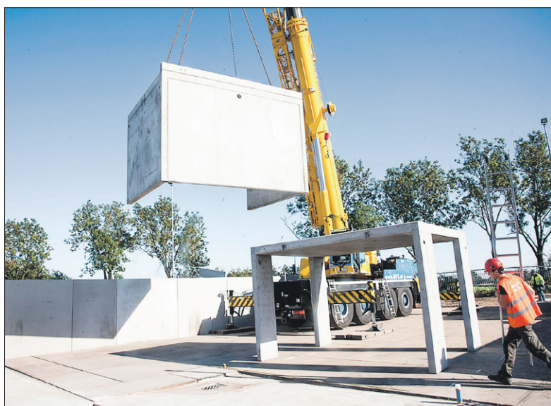
• Betonnen elementen van het bordes van De Schans worden geplaatst. De herinrichting van het afvalstoffenpark vordert gestaag. Volgens planning gaat De Schans in december weer open. Foto: Ronald Kersten
