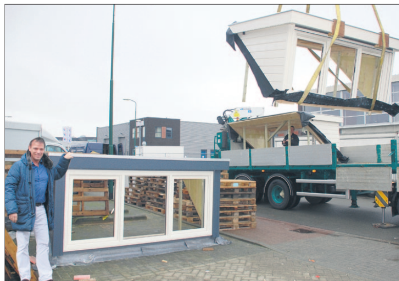
• Een van de eerste prefab dakkapellen wordt door medewerkers van Multi Kozijn op transport gezet. Deze kapellen worden traditioneel in de fabriek gebouwd en voorzien van onderhoudsvrije buitenbetimmering.
